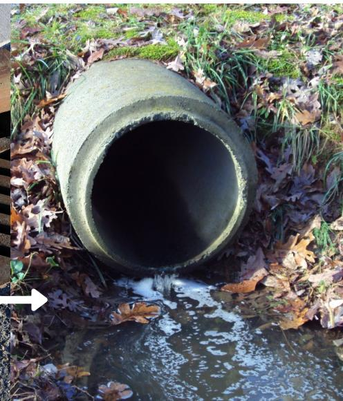
Los sistemas de drenaje pluvial están diseñados para prevenir inundaciones al recolectar aguas pluviales cuando llueve. Esta agua de lluvia fluye sobre las superficies, recoge contaminantes y finalmente se descarga en lagos, arroyos y ríos. Desafortunadamente, no existe un proceso de tratamiento en el sistema de drenaje pluvial para filtrar los contaminantes antes de que lleguen a las aguas abajo.
